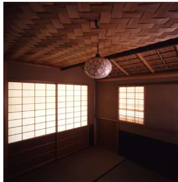
霽月化粧軒裏天井（左）。 桁・柱・隅木に北山磨丸太が使われている。裏板は黒部杉板、女竹藤蔓巻き。
